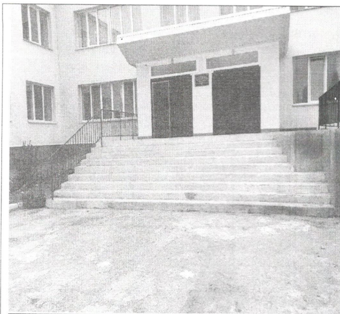
№ 1 Вход в здание (главный)
