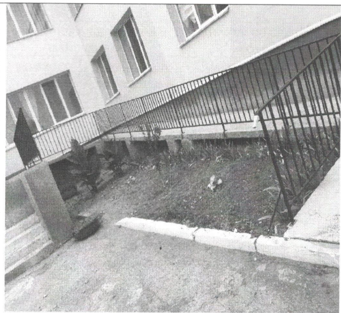
№ 2 Вход в здание (главный)
